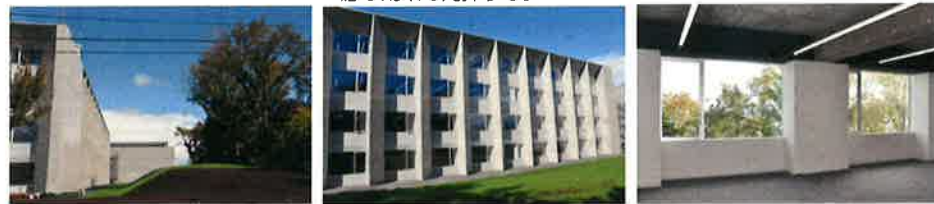
写真-03 外観（南東側）
