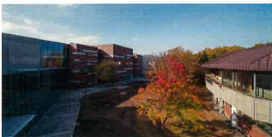
写真-02 外観（北側より）
