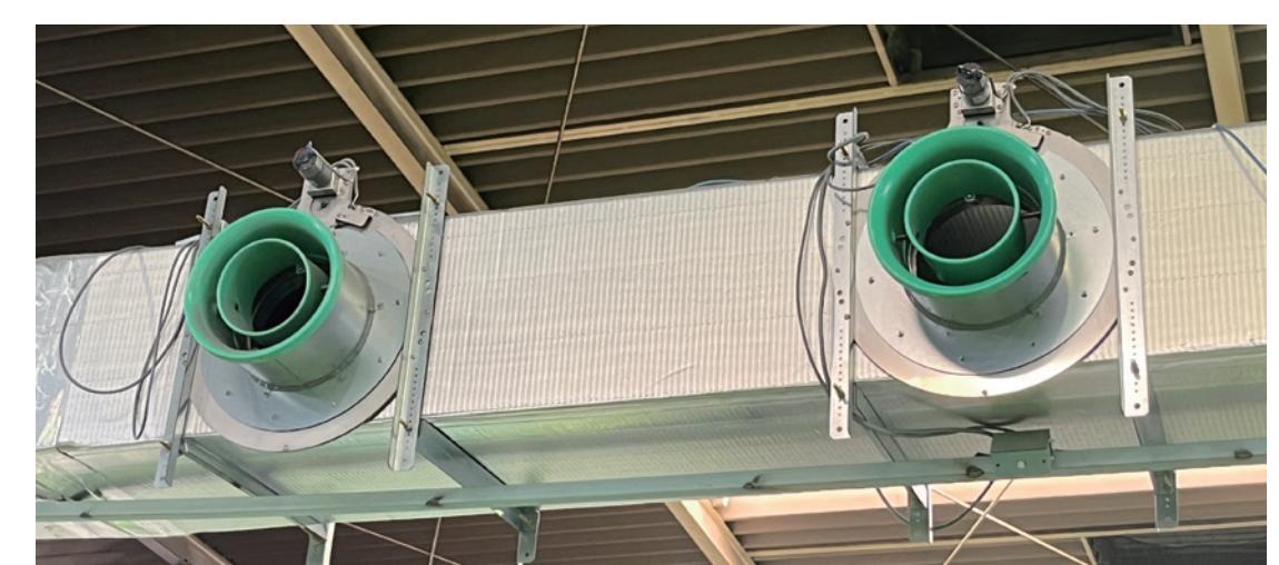
人感センサー付特殊制気口と低炭素エコ素材ル・エコダクト
